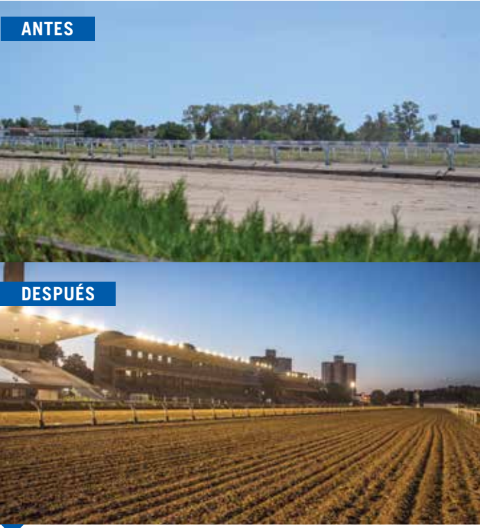
Se realizó un reacondicionamiento luminotécnico, en torres de iluminación, pista principal y auxiliares.
