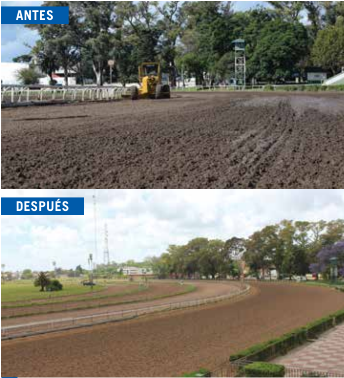
Se readecuaron las cuatro canchas del Hipódromo de La Plata. Para ello, se adquirió arena de cava, tierra negra, bolsas de cal y otros materiales que son utilizados para la mejora del piso de las canchas. Asimismo, se compraron herramientas y se alquilaron maquinarias para trabajos específicos de mantenimiento.
