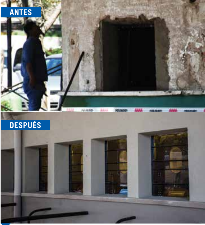
Se modificaron las ventanillas de atención al público con un nuevo sistema de cerramiento para mayor seguridad y controles.
