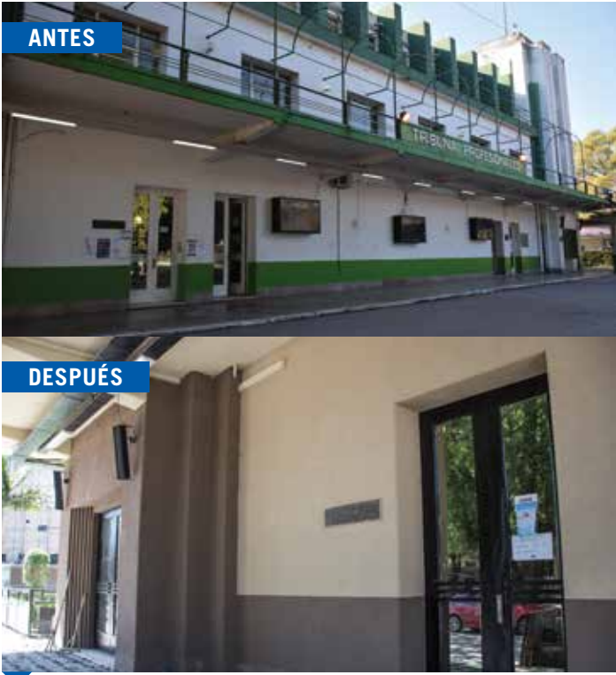
En la Oficina de la Comisión de Carreras, se creó un ambiente para el control y la verificación de las carreras, con sistema de pantallas gigantes, sector para office y mesa de reunión.
