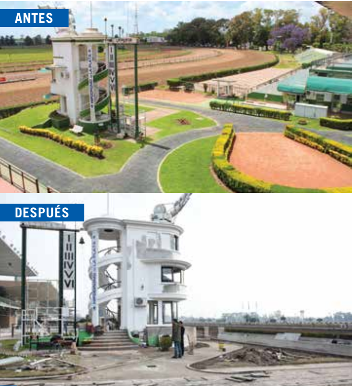
Se remodelaron el podio y la torre de control: se cambiaron los pisos de goma de la herradura donde circulan los caballos sangre pura de carrera (SPC) y se hicieron mejoras edilicias y tecnológicas en la torre de control ubicada en la línea de llegada.
